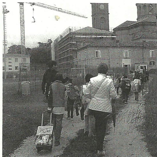
Anche il doposcuola "Bottega Compiti" ha dovuto fare i conti con il cantiere del palazzo abbaziale. Nell'immagine il primo giorno con l'ingresso dal cancello di via Guerrazzi e l'attraversamento del campo sportivo. Sulla sfondo la ormai "mitica" gru.
