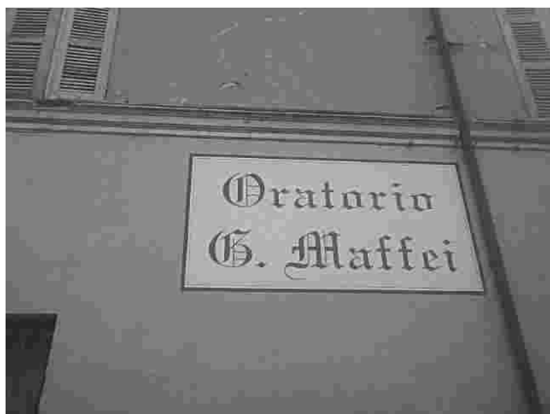
Questa scritta or non è più. Sacrificata al rifacimento dell'intonaco esterno tornerà più bella, splendente e fiera di prima
